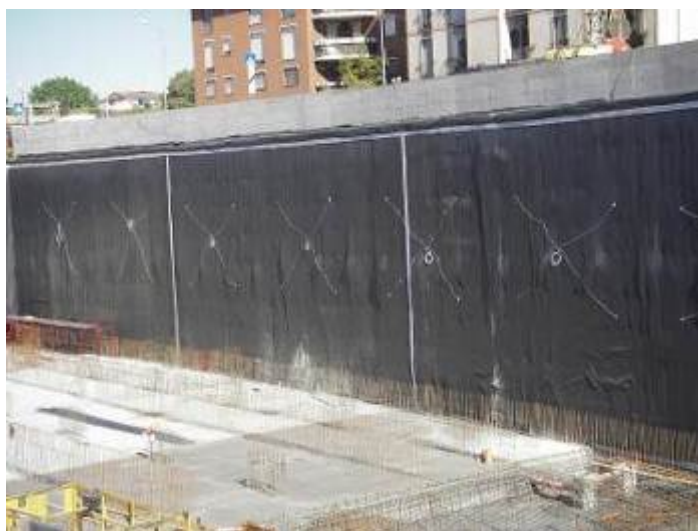
Figura 6. Sistema de impermeabilização com membranas sintéticas compartimentado reparável para fundações.
