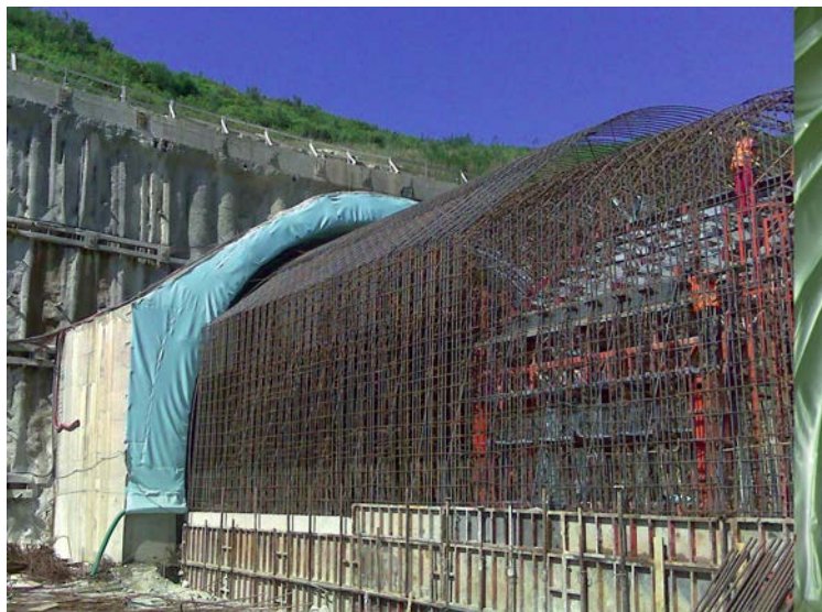
Figura 3. Túnel com geomembrana de PVC.
