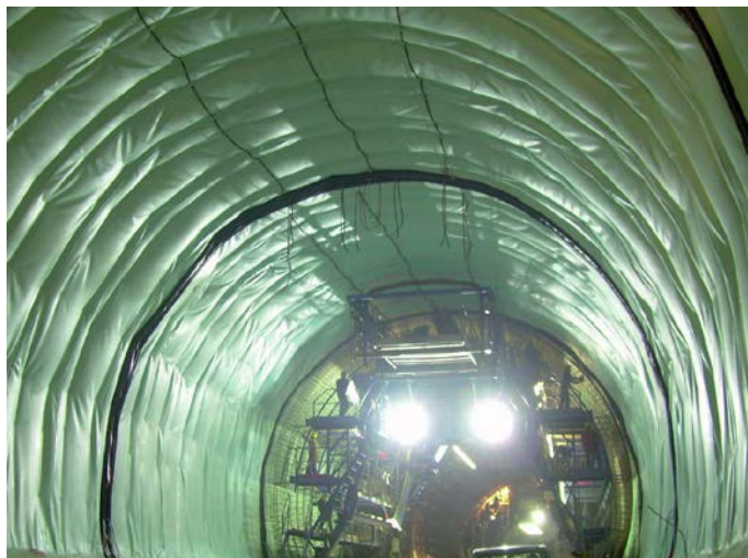
Figura 5. Tunel com geomembrana compartimentada.
