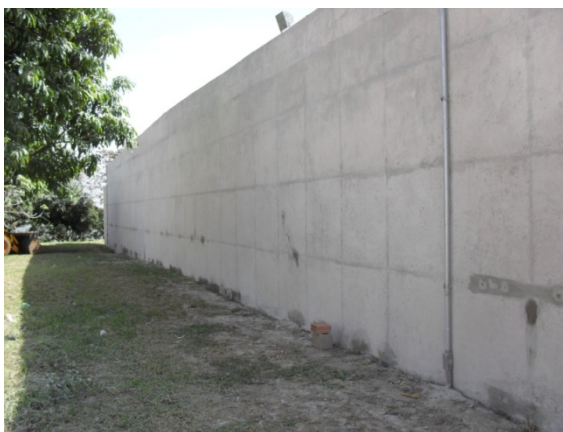
Fig. 9 – Parede externa do reservatório preparada para a realcalinização e silicatização do concreto
