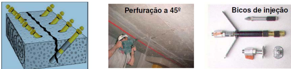
Fig. 7 – Imagens do processo de injeção em fissuras e trincas (Fonte: Google)
