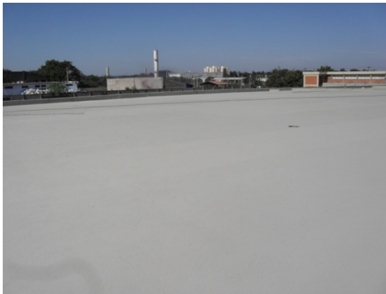
Fig. 10 – Laje do reservatório após impermeabilização
