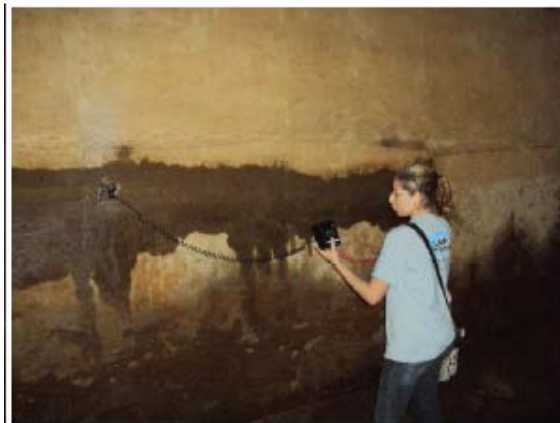
Fig. 1 – Ensaio de potencial de corrosão
