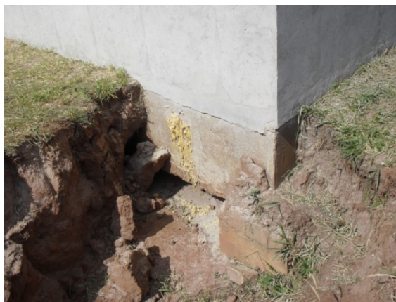
Fig. 7 – Imagens do processo de injeção em fissuras e trincas (Fonte: Google)
