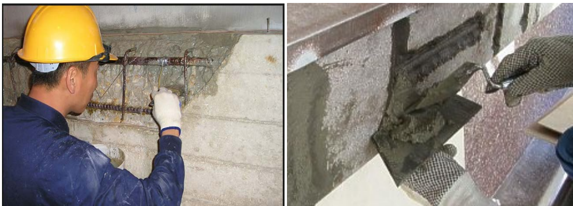
Fig. 4 e 5 – Aplicação de argamassa polimérica de reparo (Fonte: Google)
