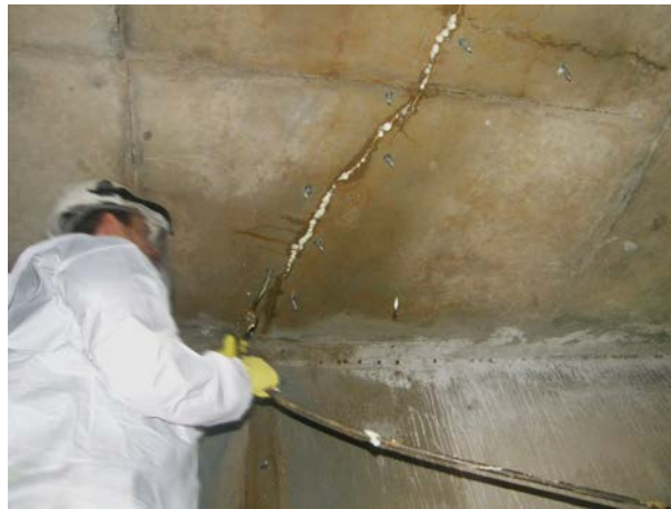
Ilustração posicionamento dos bicos de injeção.
