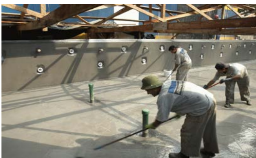
Impermeabilização de piscina com poliuretano
