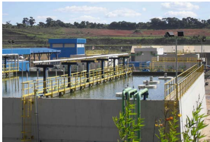
Impermeabilização de Estações de tratamento de esgoto com poliuretano
