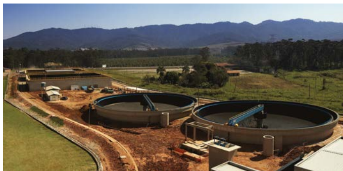
Impermeabilização de Estações de tratamento de água e esgoto com poliuretano
