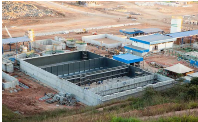
Impermeabilização de Estações de tratamento de esgoto com poliuretano
