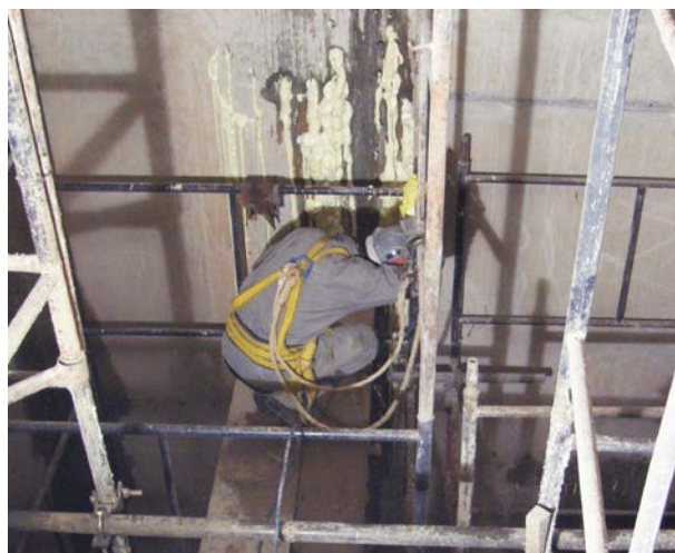
Injeção de Poliuretano Hidroativo
