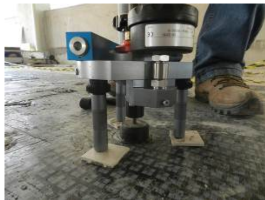
Imagem 9 - Execução do ensaio de arrancamento
