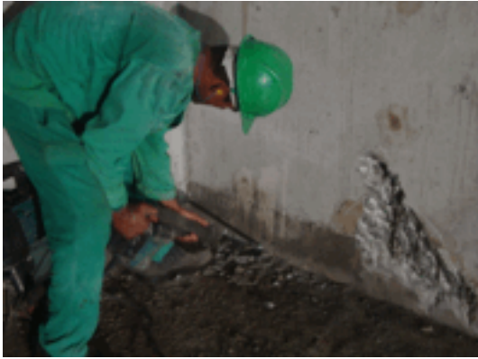
Foto 6 – Remoção de concreto em bicheira.
