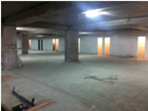
Foto 15 – Vista interna do subsolo seco.
