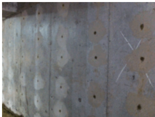
Foto 5 – Tamponamento dos furos de tirante da cortina.
