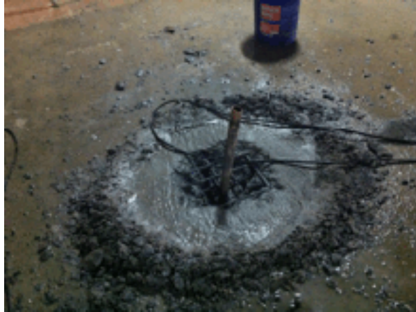
Foto 10 – Tamponamento definitivo de furo após a remoção da ponteira de rebaixamento.
