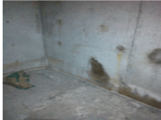
Foto 7 – Reparo com argamassa de reparo
