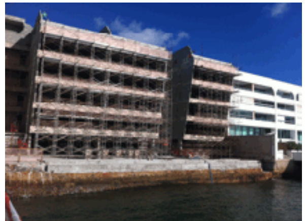
Foto 16 – Estrutura em fase de acabamento.
