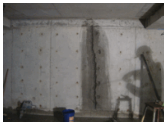
Foto 9 – Tratamento de fissura.
