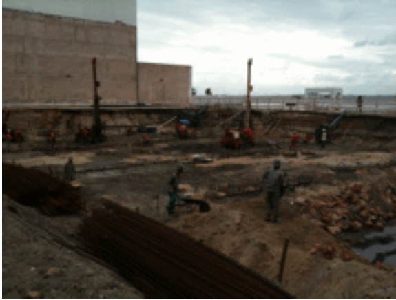
Foto 11 - Subsolo escavado com rebaixamento do lençol
