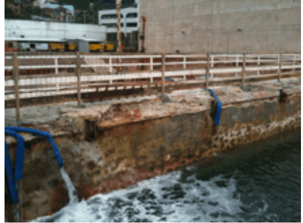
Foto 12 – Bombeamento do sistema de rebaixamento. Maré alta.
