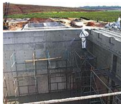
Ficha técnica Local: Campinas (SP) Especificação e supervisão técnica: Casa D'Água Tecnologia para Construção Execução: Metta Serviços Técnicos e Construtora Lix da Cunha
