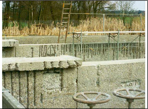
Figura 3 – Ataque de ácido sulfúrico biogênico
