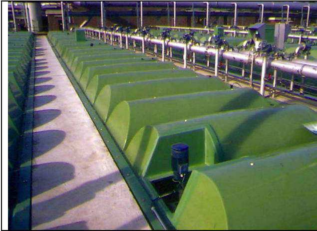
Figura 2 – Instalação de tampas sobre aeradores de esgoto
