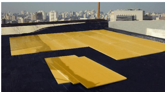
Figura 8 – Laje obra Juscelino Kubitscheck (Impermeabilizadora Amplacom)
