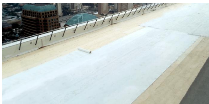
Figura 11 – Laje obra Alwitra (Alwitra)
