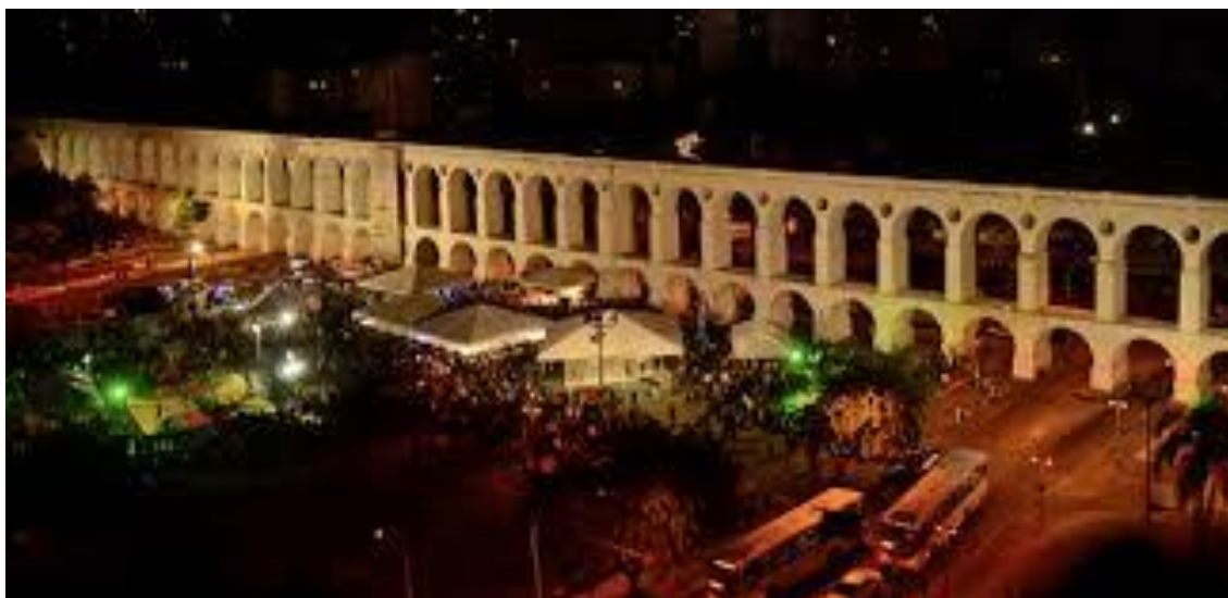
Foto 07 – Vista área da obra restaurada e com iluminação instalada Fonte: Escola Curt Brandes
