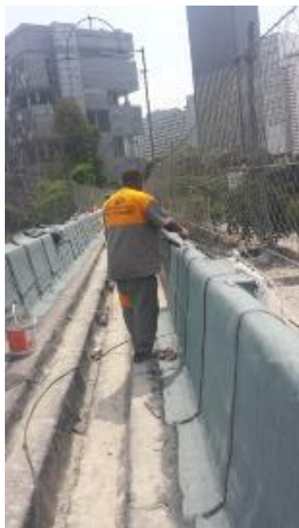
FOTO 04 – Aplicação da manta ardosiada
