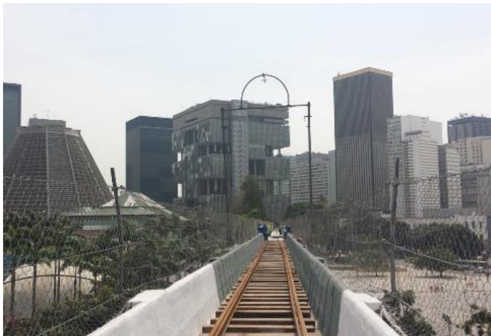
FOTO 06 – Vista da área vertical impermeabilizada
