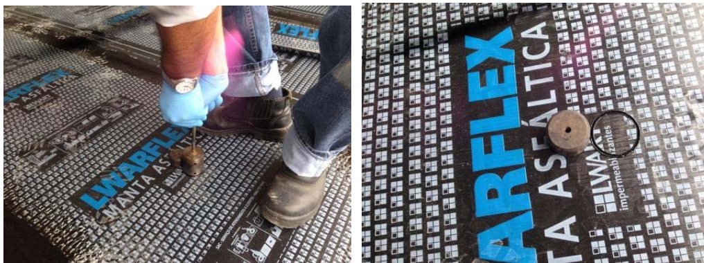
8- Perfuração da manta para colagem da pastilha
