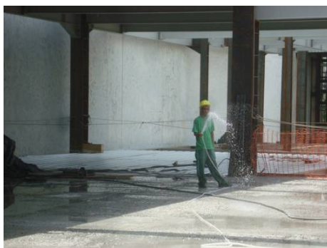
Figura 10- Processo de irrigação
