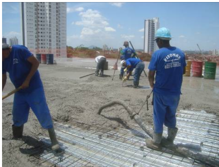
Figura 08-Nivelamento
