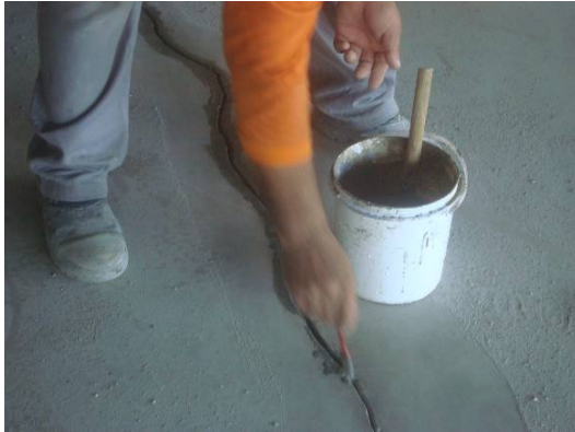
Figura 14 - Aplicação do graute para tratamento da fissura.
