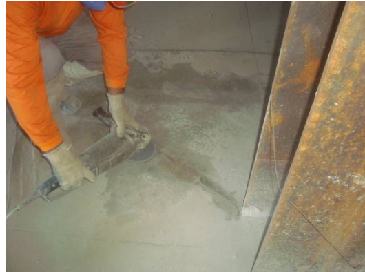
Figura 15 - Realização de acabamento após secagem
