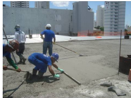
Figura 09-Sarrafeamento e Vassourado
