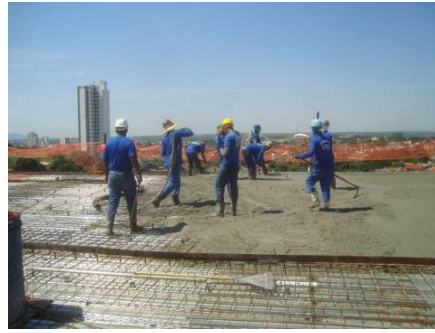
Figura 07-Espalhando o concreto
