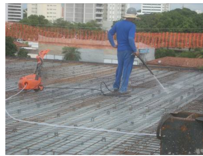
Figura 05-Limpeza do Steel deck com jato de água de alta pressão.
