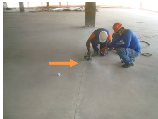
Figura 13 - Abertura da fissura para aplicação do graute.
