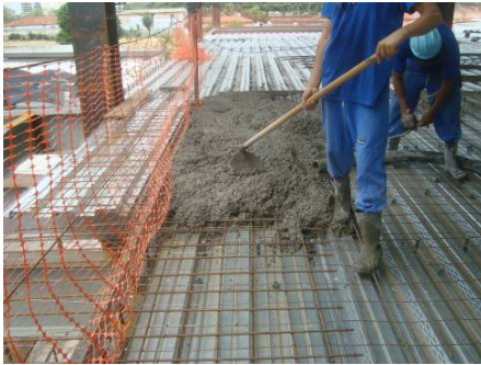
Figura 06-Início da Concretagem
