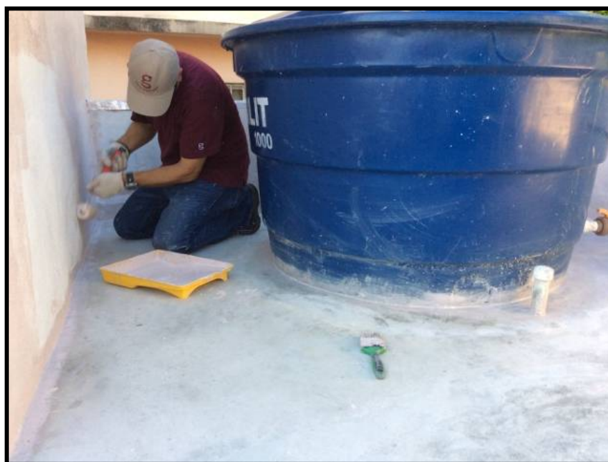
Foto 1 – Aplicação de imprimação com “primer” de base epoxídica.
