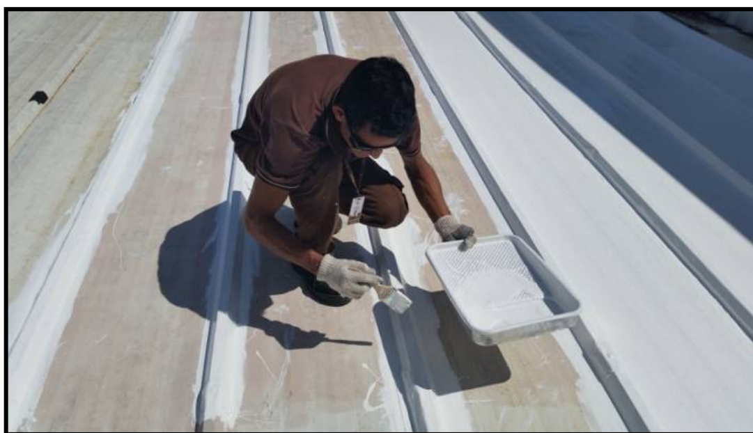
Foto 4 – Aplicação da resina de silicone formando a membrana impermeabilizante sobre o telhado.
