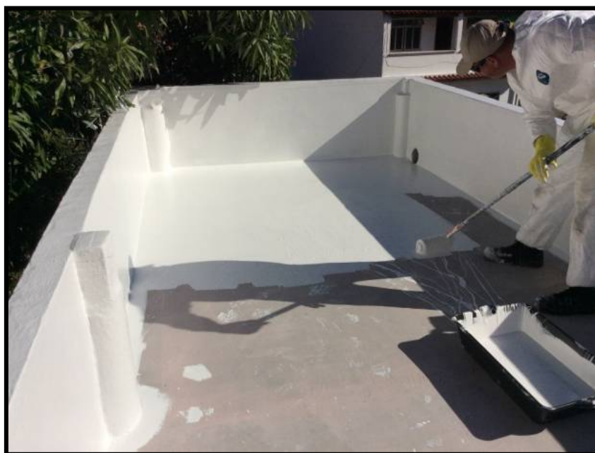
Foto 2 – Aplicação da resina de silicone para formação da membrana impermeabilizante.
