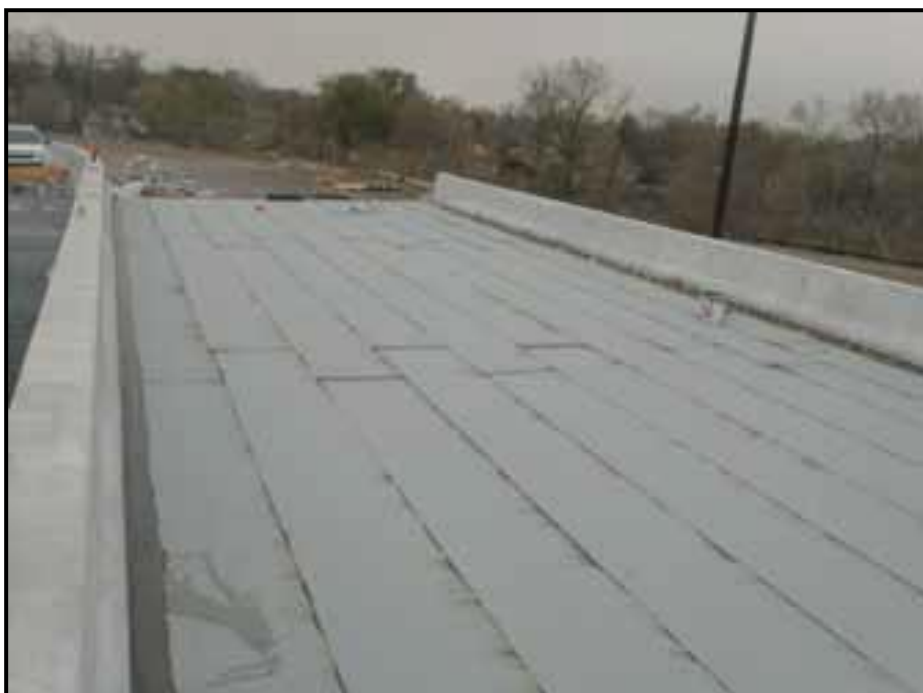
Foto 5 – Tabuleiro da superestrutura de ponte impermeabilizado com manta asfáltica pré-fabricada (NCHRP Synthesis 425, 2012).
