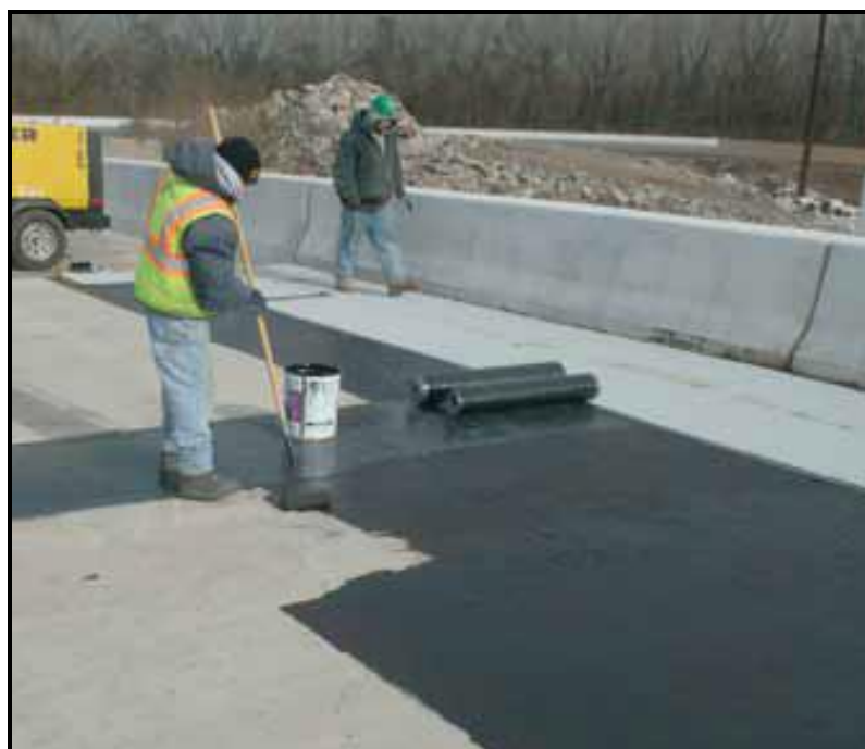
Foto 3 – Instalação da impermeabilização sobre o tabuleiro da superestrutura de ponte (NCHRP Synthesis 425, 2012).
