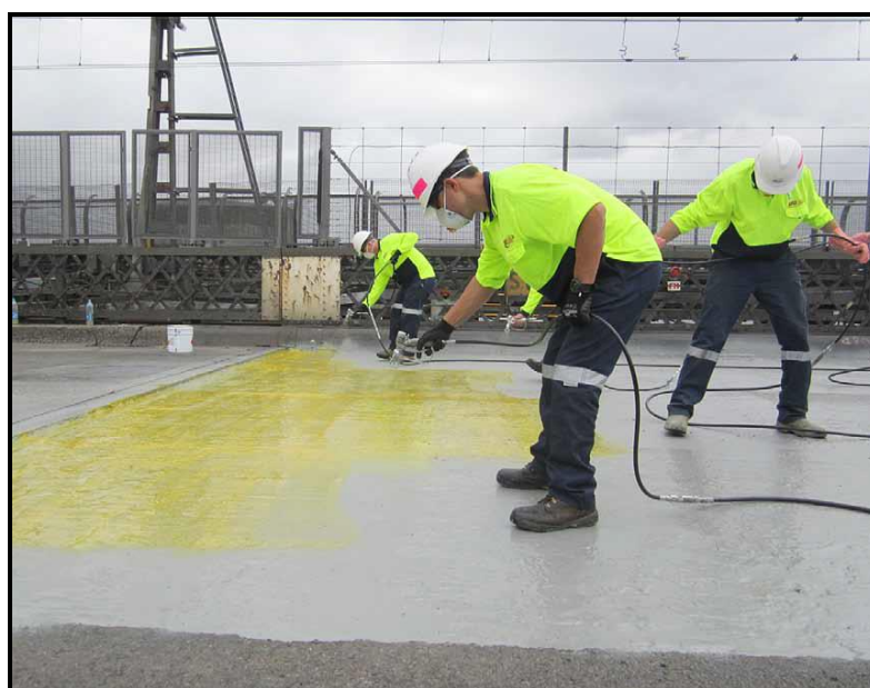
Foto 7 – Membrana de poliureia aplicada com “spray” sobre tabuleiro de ponte (SIKA N° 38.12, 2012).
