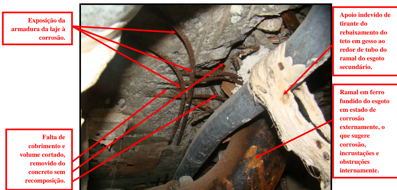
Foto 6 – Detalhe de outra área de teto de banheiro social do ap. 103 (da Autora). Evidências da realização de serviços precários na montagem das instalações de esgoto do ap. 203 (dos Réus); tendo como resultado a exposição da armadura da laje à corrosão, falta de cobrimento e volume cortado/removido do concreto sem recomposição. Além do que, observa-se apoio indevido de tirante do rebaixamento do teto em gesso ao redor de ramal de tubo em chumbo do esgoto secundário. Note-se, também, que o tubo em ferro fundido ref. a ramal do esgoto primário evidencia corrosão externamente, o que sugere corrosão, incrustações e obstruções internamente.
