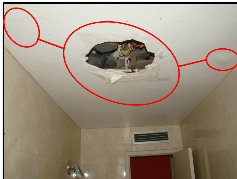
Foto 1 – Detalhe da área de teto de banheiro social do ap. 103 (da Autora), apresentando anomalias e danos no teto rebaixado em gesso, pinturas, além de anomalias estruturais localizadas (corrosão de armadura e desagregação do cobrimento do concreto), como efeitos de infiltrações ocorridas através da laje teto e devido a vazamentos ocorridos em instalações de água e esgoto adjacentes, além de indícios da realização de serviços de reparos precários.
