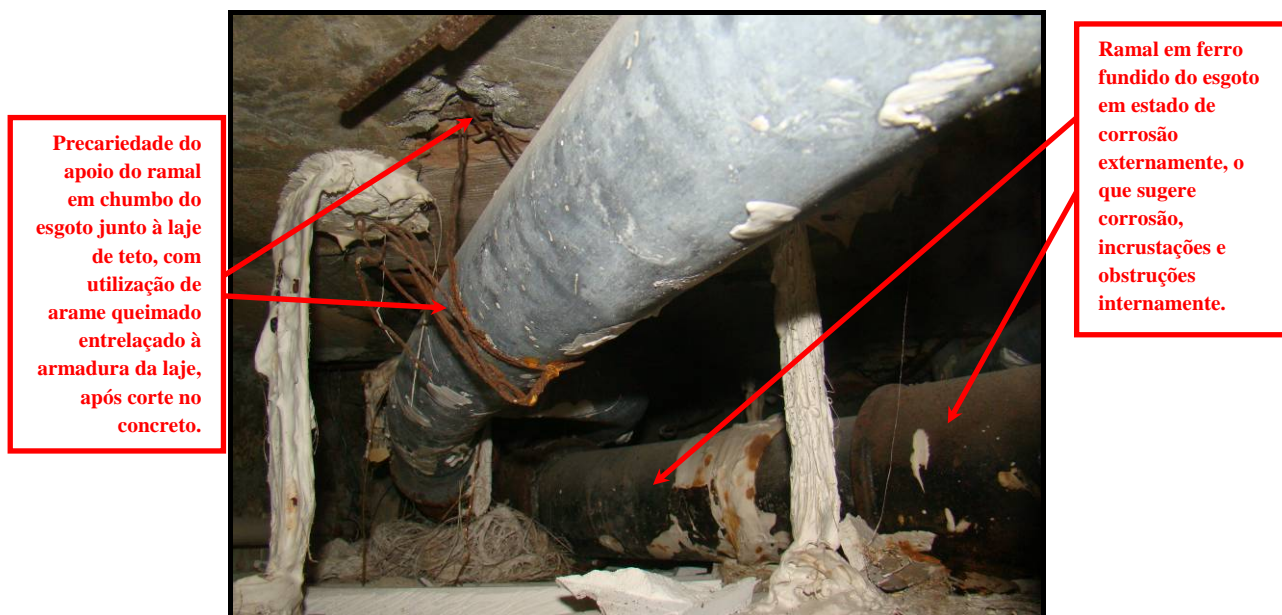
Foto 5 – Detalhe de ramais das instalações de esgoto do ap. 203 (dos Réus) sobre a área de banheiro social do ap. 103 (da Autora), um deles com segmento em chumbo (aquele oriundo da caixa sifonada) e o outro em ferro fundido (principal, o qual vai esgotar na coluna do esgoto). Note-se precariedade no apoio do ramal em chumbo junto à laje de teto, com utilização de arame queimado entrelaçado à armadura da laje, após corte no concreto. Ademais, observa-se que o tubo em ferro fundido evidencia corrosão externa, o que sugere corrosão, incrustações e obstruções internas.
