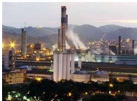
Figura 3 - Aplicação moldada in loco com membrana epoxídica – CSN (IMPERMEAR, 2015)
