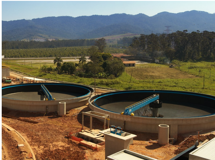
Figura 2 - Tanques impermeabilizados com membrana de poliuretano - ETE Mogi Sanear.
