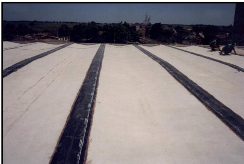
**Foto 8 – Impermeabilização tipo E das juntas das vigas-telhas “gaivotas” no CIEP de Tocos, Campos dos Goytacazes, RJ, 1994.**
