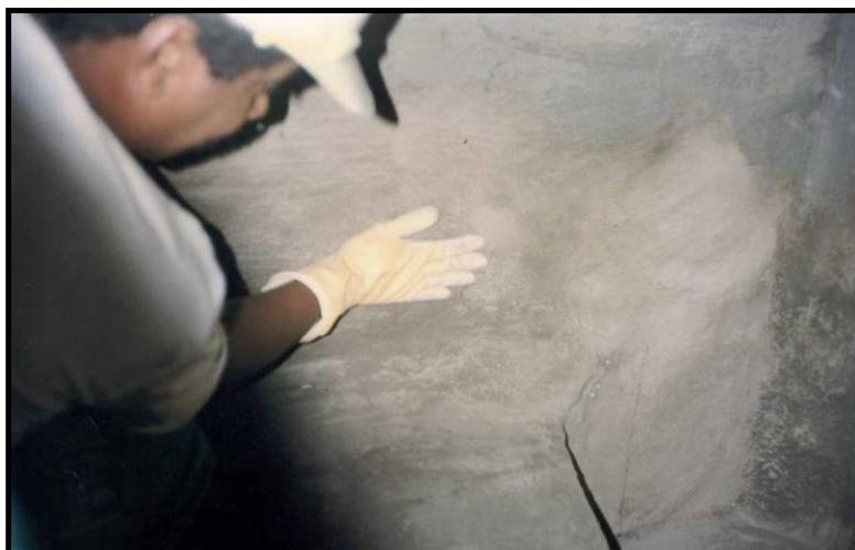
Foto 9 – Tratamento do concreto com sistema de cristalização na cisterna d'água do P2 da UENF, 1994.
