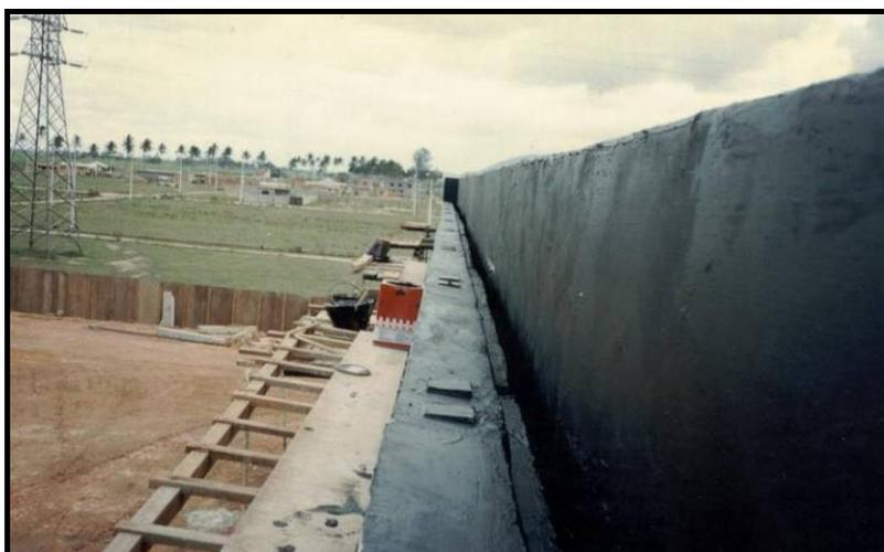
**Foto 10 – Impermeabilização tipo J da viga-calha com solução asfáltica elastomérica, 1993.**
