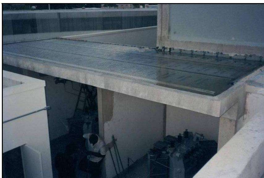
**Foto 7 – Impermeabilização tipo D na laje sobre subestação durante ensaio hidráulico, na UENF, 1993.**
