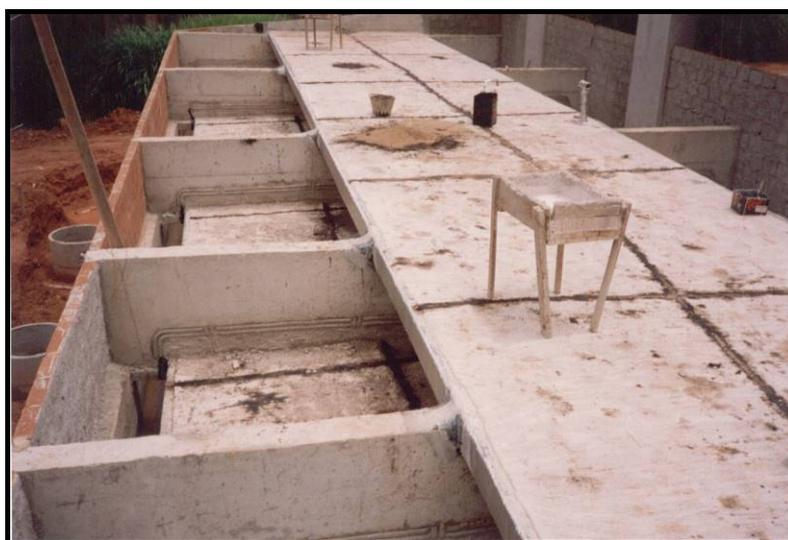
**Foto 6 – Impermeabilização tipo B com tratamento térmico em espuma de cimento e proteção mecânica primária em argamassa, antes da aplicação do plaqueamento em argamassa c/juntas, na UENF, 1993.**
