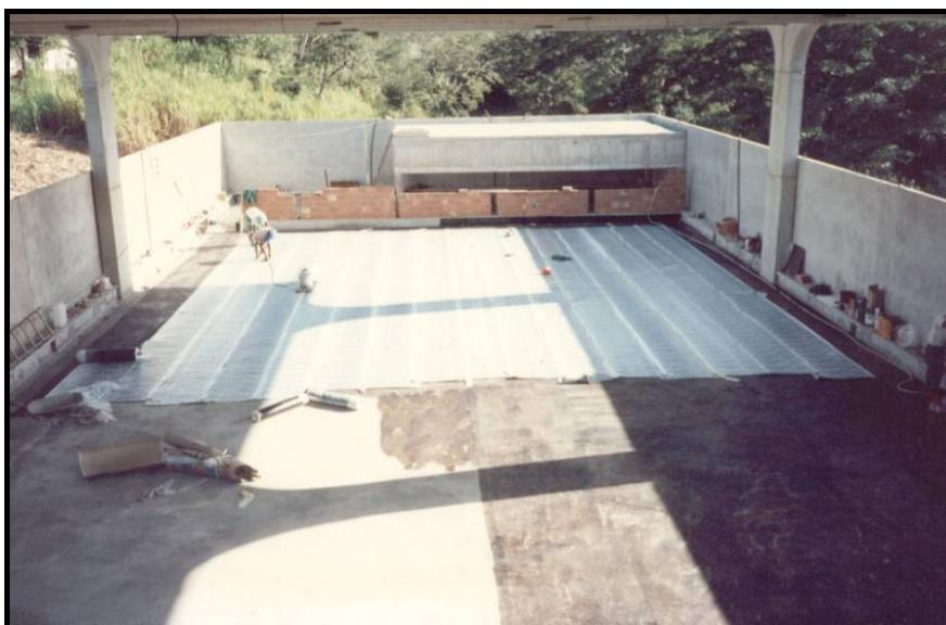
**Foto 2 – Impermeabilização em laje de cobertura do CIEP tipo compacto, em Laje do Muriaé, RJ, 1993.**
